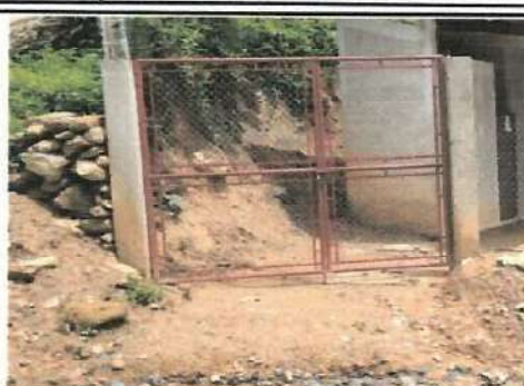
Foto 2: Mejoramiento de porton con techo.
