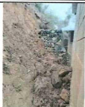
Foto 1: Mejoramiento muro de contención para detener los derrubes en el establecimiento educativo, ya que los derrumbes son un riesgo para el bienestar de los niños y niñas del establecimiento.
